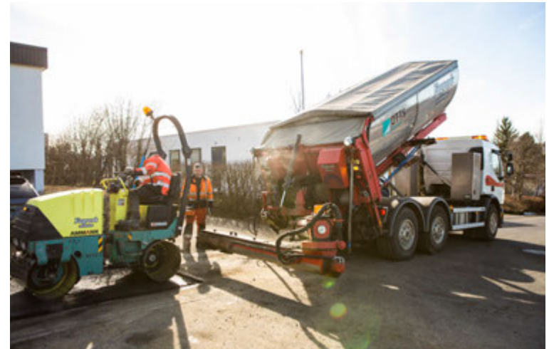
Lítill hiti tapast úr malbikinu með þessari aðferð.
