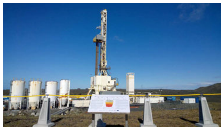
Djúpborunarverkefnið er einstakt á heimsvísu.
