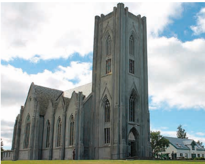
■ Landakostskirkja, byggð á árunum 1925-1929, hönnuð af Guðjóni Samúelssyni arkitekt.
