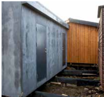
Saunahúsið var flutt á staðinn fullbúið og híft á sinn stað í lok október.
