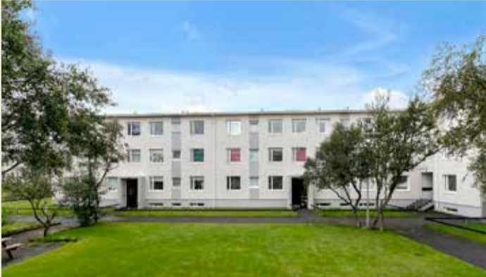
Maríubakki er ein þriggja gatna sem hafa hlotið feegrar- viðurkenningu í Breiðholti.
