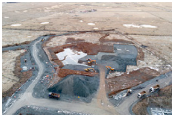
■ Framkvæmdir við Stekkjaskóla eru að hefjast.
