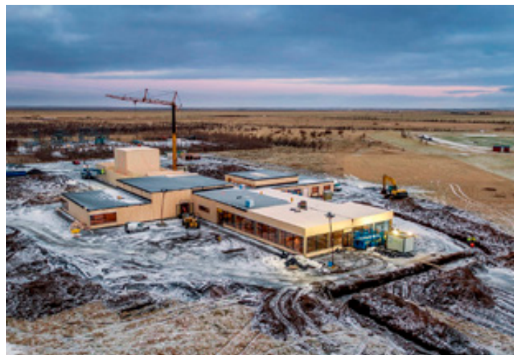
■ Einingarnar koma beint úr verksmiðju í Austurríki og í þeirri röð sem húsini eru reist hér á landi.
