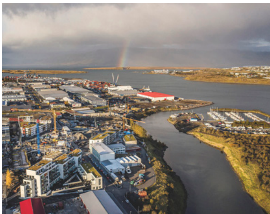
■ Hábrúin færi yfir Kleppsvíkina og þvert yfir hafnarsvæðin ofan við miðja mynd. Myndir: Vegagerðin.
