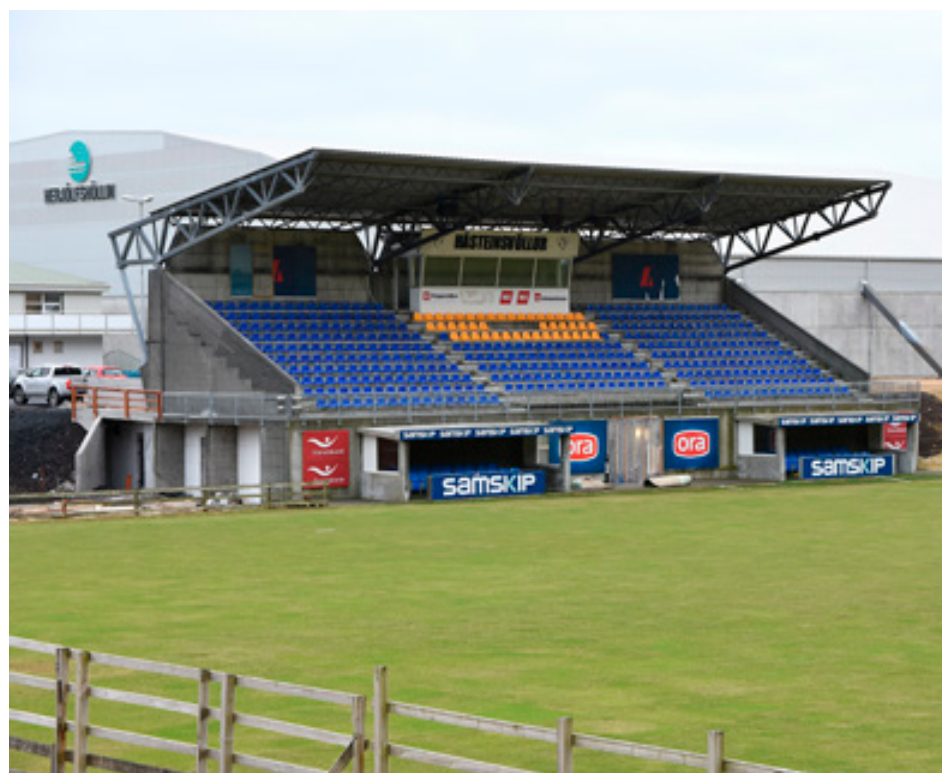
■ Við Hásteinsvöll er verið að byggja nýja búningaklefa undir stúkunnari á vellinum.
