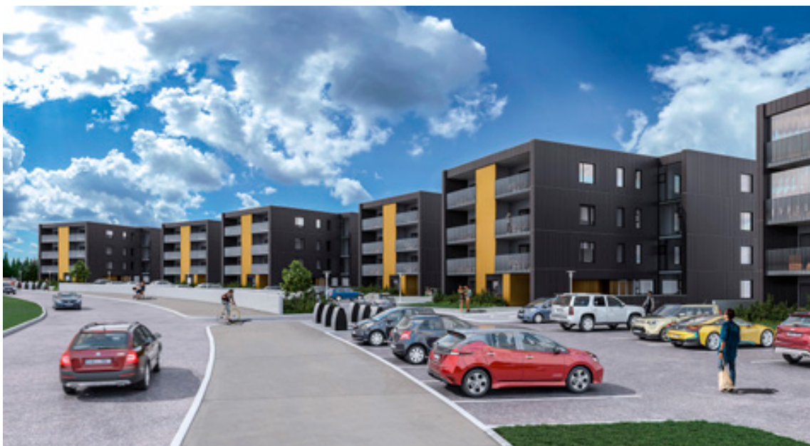
■ MótX er að ljúka byggingu 128 íbúða við Elliðabraut í Norðlingaholti í Reykjavík.
