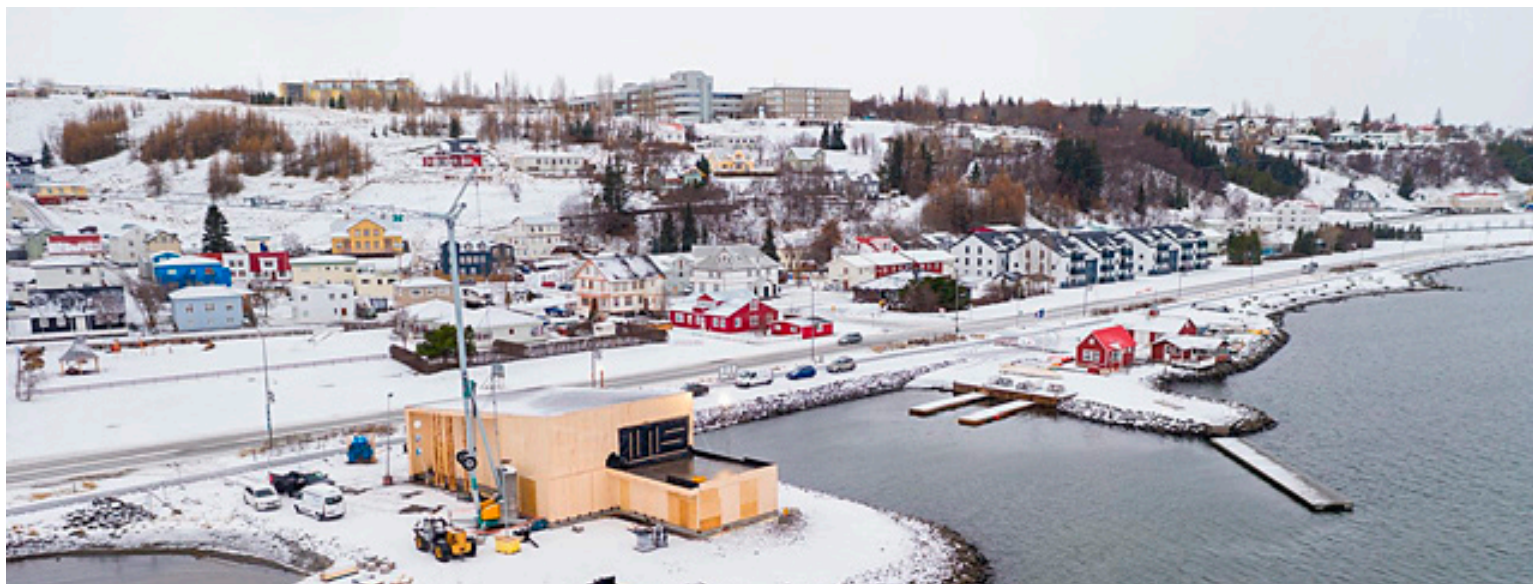
■ Element hefur reist um 80 krosslímd hús hér á landi á síðustu fimm árum, stór og smá. Hús fyrir Siglingaklúbbinn Nökkva á Akureyri er nú í byggingu.
