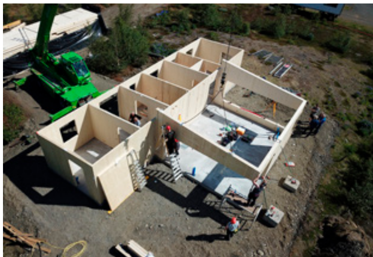
■ Byggingarhraði krosslímdra húsa er mikill. Áætla má að hús rísi á um fjórðungi þess tíma sem færi í að steypa upp.
