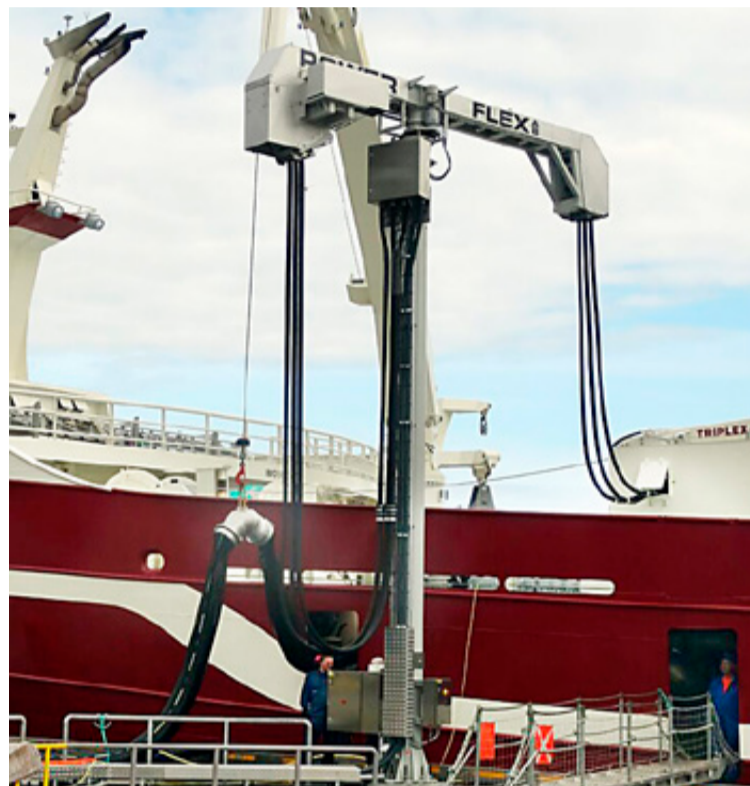
■ Rafmagnskaplarnir frá landi sem tengjast skipum Síldarvinnslunnar.
