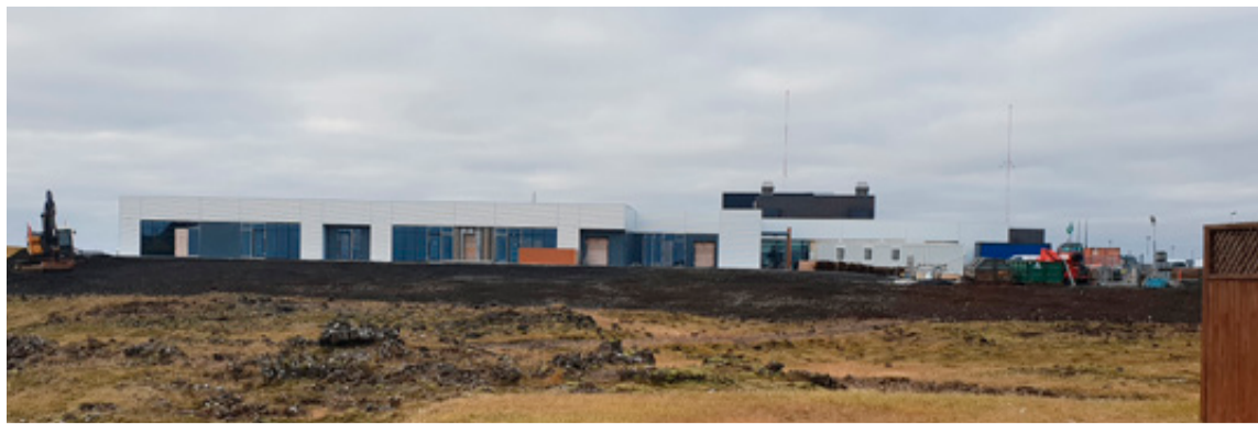
■ Framkvæmdir við stækkun Hópsskóla standa nú yfir.
