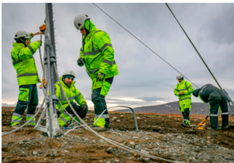
■ Starfsmenn verktakafyrirtækisins Elnos vinna að uppsetningu masturs Kröflulínu 3.
