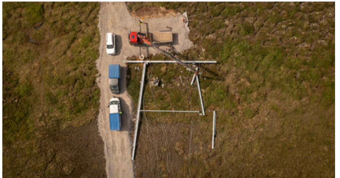
■ Staurastæða í Hólasandslínu í samsetningu.
