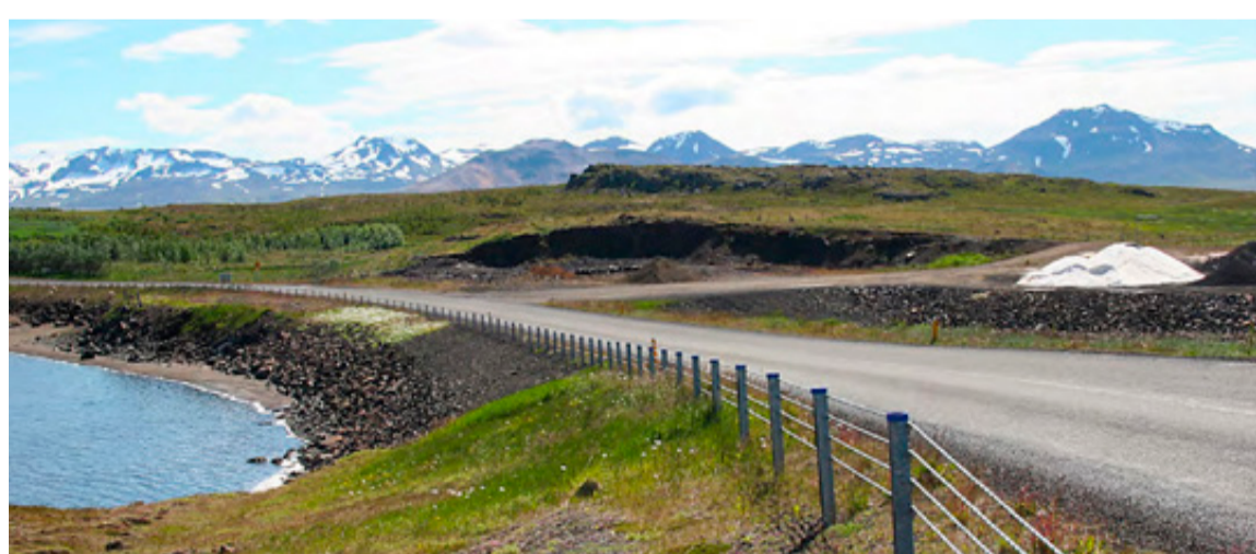
■ Víravegríð meðfram Stykkishólmsvegi um Vogsbotn sem sett var upp fyrir allmörgum árum.
