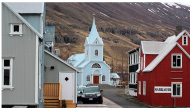
■ Frá Seyðisfirði. Með tengingu byggðarlaganna við Hérað með göngum undir Fjarðarheiði fæst mun betri hringtenging milli allra byggðarlaga á Austurlandi. Áætlað er að gröftur Fjarðarheiðarganga við báða stafna hefjist haustið 2023.
