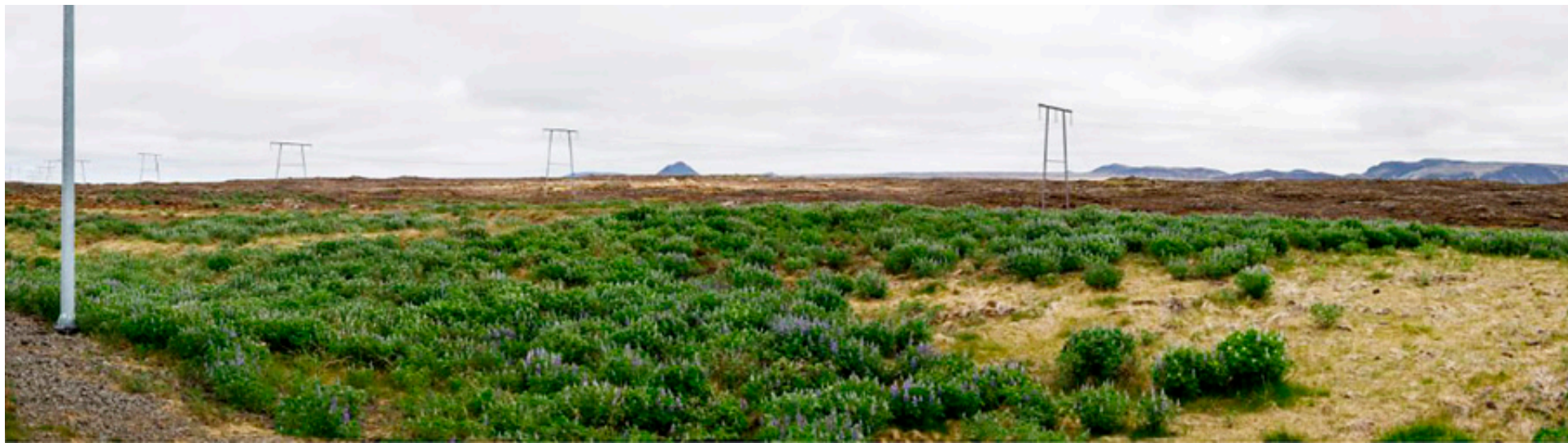
■ Fyrirhuguð Suðurnesjalína 2, séð frá gatnamótum Reykjanesbrautar og Voga.
