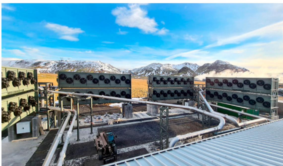
■ Climeworks hefur sett upp búnað við Heilishaiðarvirkjun sem beinlínis sagnar koltvísýringinn úr andrúmsloftinu. Carbfix tækni er svo notuð til að geyma hann í jarðlögum um þúsundir ára.
