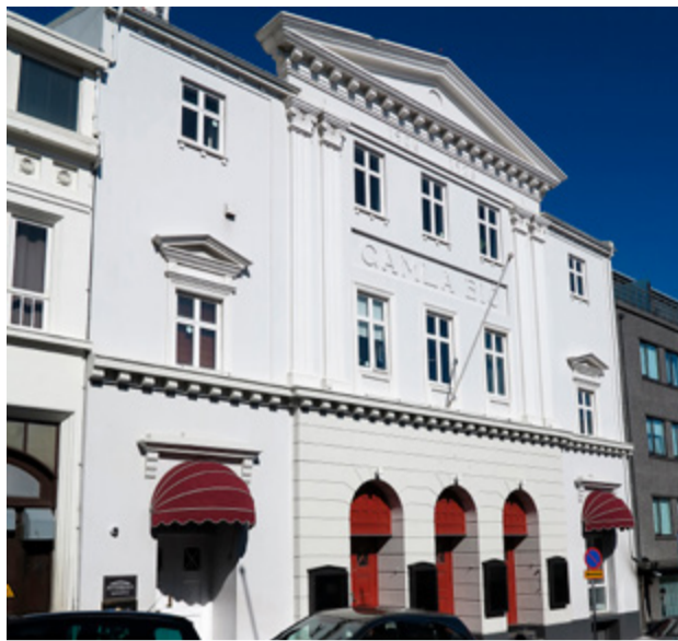
■ Gamla bíó, Ingólfsstræti 2a. Húsið er byggt í hreinum nýklassískum stíl og er ein af merkustu byggingum í Reykjavík frá tímabili steinsteypuklassíkur og eitt helsta verk Einars Erlendssonar í listrænu tilliti.
