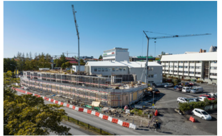
■ Bygging 35 íbúða fyrir almennan markað á Snorrabraut 60 gengur vel og er gert ráð fyrir að þær verði tilbúnar til afhendingar á haustmánuðum 2023.
