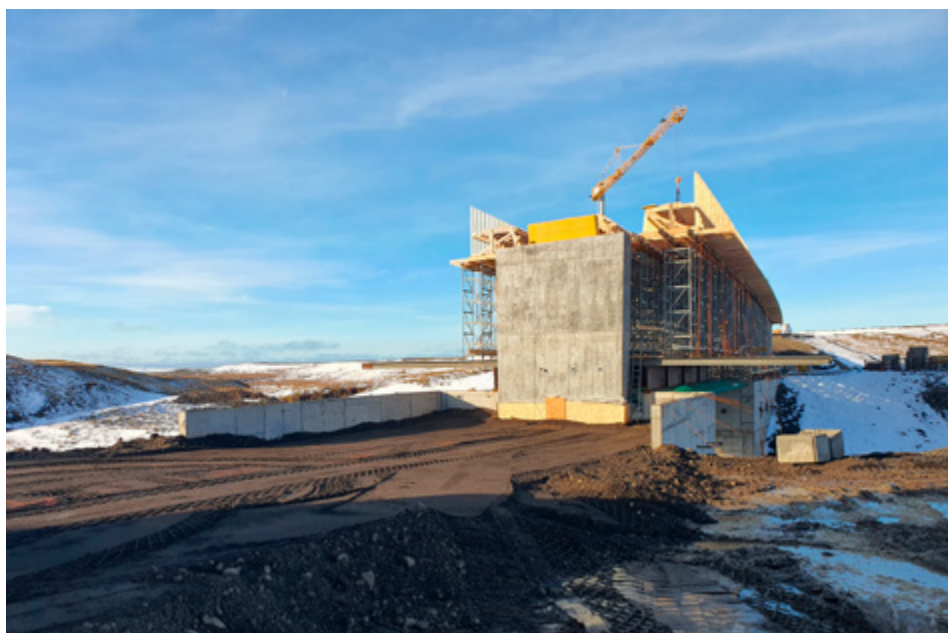
■ Eitt af stærri yfirstandandi nýframkvæmdaverkefnum í vegakerfinu er nýr kafli og brúargerð í Refasveit í Austur-Húnavatnssýslu.
