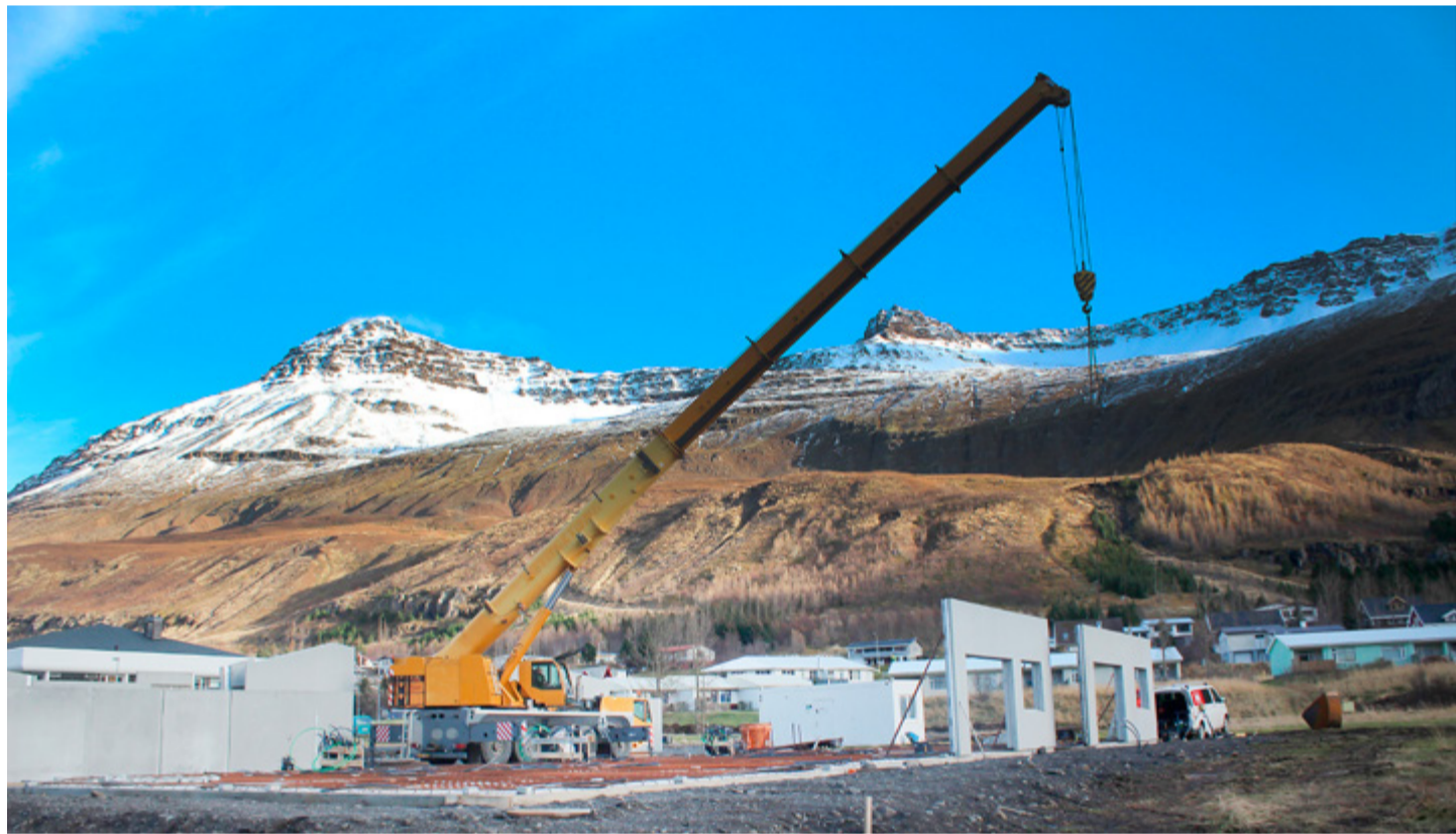
■ Á gamla knattspyrnuvellið á Seyðisfirði er verið að byggja fjögurra íbúða raðhús og íbúðir fyrir eldri borgara í átta íbúða kjarna.
