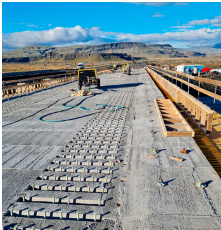
■ Brúin yfir Hverfisfljót verður 74 m löng og 10 m breið. Ljósmynd: Vegagerðin.
