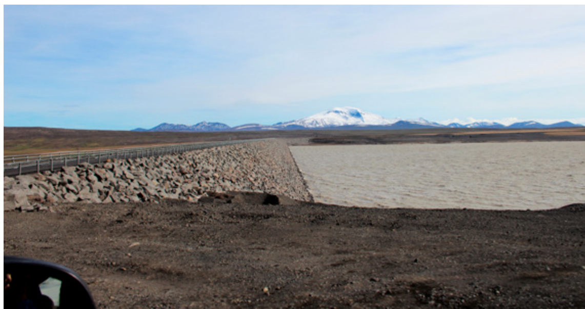
■ Við Hálslón, miðlunarlón Kárahnjúkavirkjunar.
